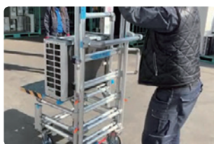
・エアコン室外機の運搬
