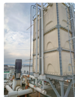
<散水タンクを屋上に設置>
