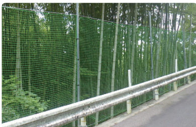
防止ネットの設置写真（大向地区）
