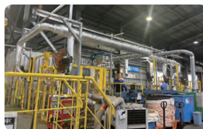
冷蔵庫解体ライン
