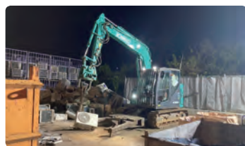
2022 年実施 エアコン重機解体
