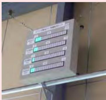
エアコン手解体ライン内の粉塵を、4箇所測定し、粉塵監視モニターで管理を行っている。粉塵の基準は、労働基準よりはるかに厳しい三菱電機(株)の環境基準値を採用している。
