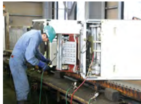
冷媒フロン回収作業
