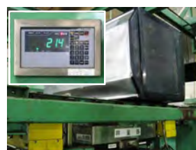
冷蔵庫投入ピッチ制御
