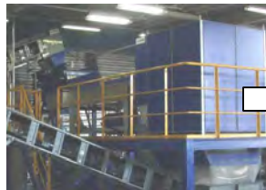
配線除去装置の外観
