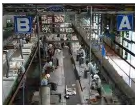
解体ライン全景
