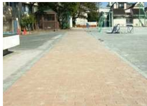
写真2： 東京都板橋区立志村第一小学校で試験 導入されている使用済みブラウン管パ ネルガラスを活用した舗道用ブロック
