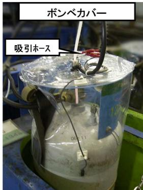
ポンベ上部に透明のカバーを取り付けることで微妙な漏洩も検知する
