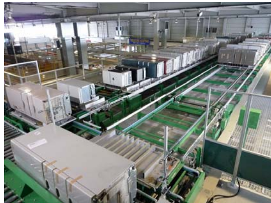
2階 自動保管ライン
