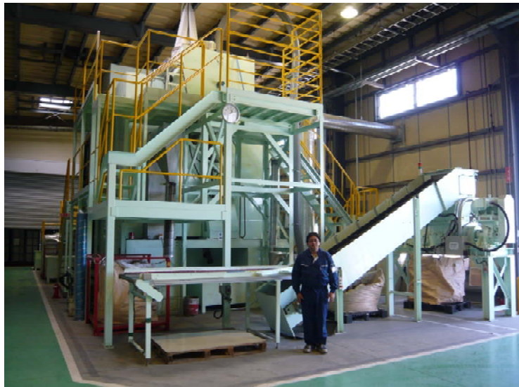
有機物分解処理設備外観
