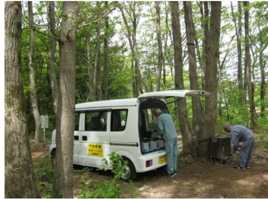
パトロール 監視カメラ設置中
