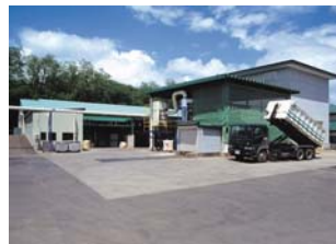
破砕選別設備
