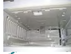
瞬冷凍室天井仕切り
