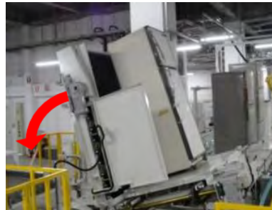
新ライン：冷蔵庫転倒装置
