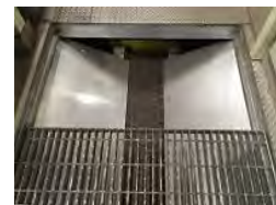
グレーチング床(ねじ回収コンベア)
