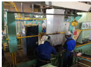
熊本地震の被災冷蔵庫処理
