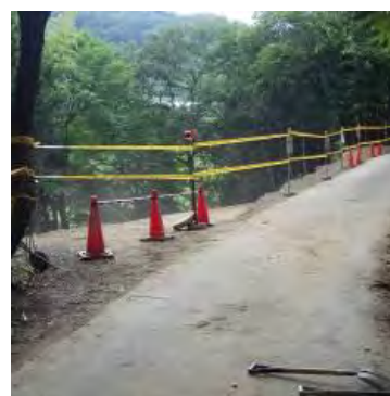
撤去・回収後の現場
