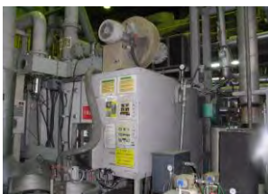
断熱材フロン回収システム
