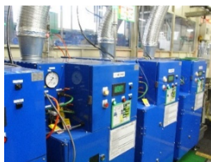
イソブタン・冷凍機油処理装置
