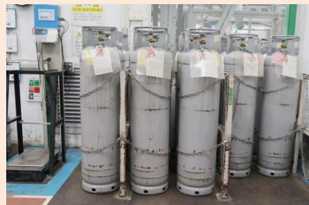
④ ポンベ保管庫（40℃以下）で保管。フロン検知器等で漏れの有無を確認します。
