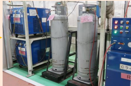
③ 冷媒フロンの種類別にポンベを区分けし回収。冷媒フロンが漏れないことを回収中も重量センサー等で確認します。
