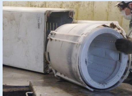
④洗濯槽を取り外します。
