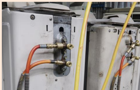
② カプラーをセットし、冷媒フロンを回収します。
