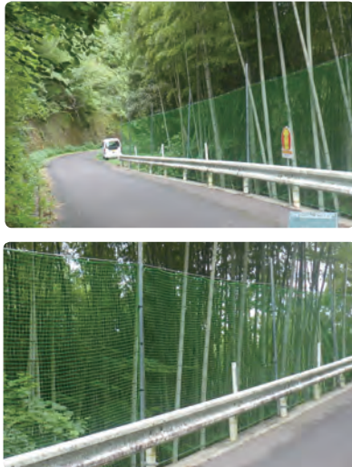
防止ネットの設置写真（大向地区）
