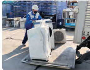
荷降ろし作業の様子
