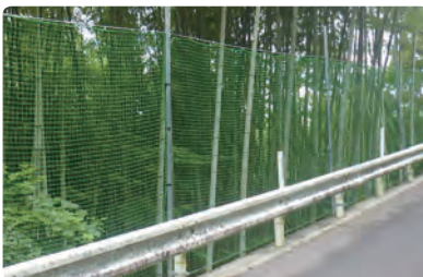
防止ネットの設置写真（大向地区）
