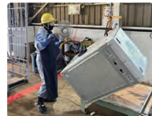
エアコン室外機と同じ1点吊り
