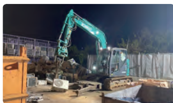
2022年実施 エアコン重機解体
